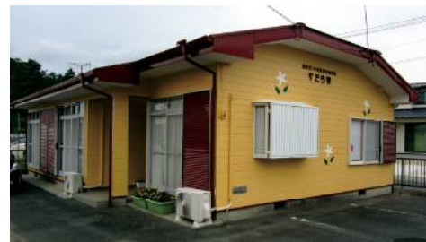
工事完了後の すだち寮
