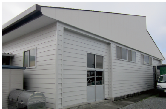
訓練棟の外壁・屋根の補修、塗装を塗り直しました。
